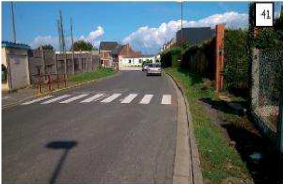
Prolongement de la voie verte par réduction de la largeur de chaussée.
